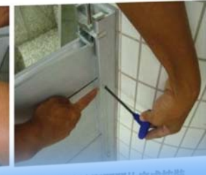
六、側邊迫緊閘門片完成按裝
