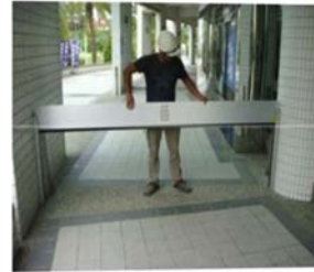
三、插入閘門按裝第一片 (有防水膠膠止水墊之閘門片)
